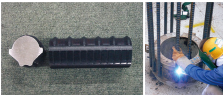
「New J-BAR」(開先付き異形棒鋼)と現場施工の様子
