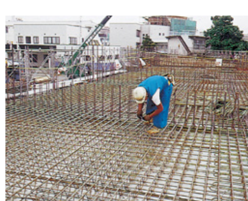
「ファブデッキ」(現場施工の様子)
