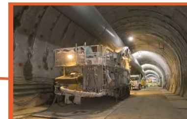
北海道新幹線トンネル (施工中)
